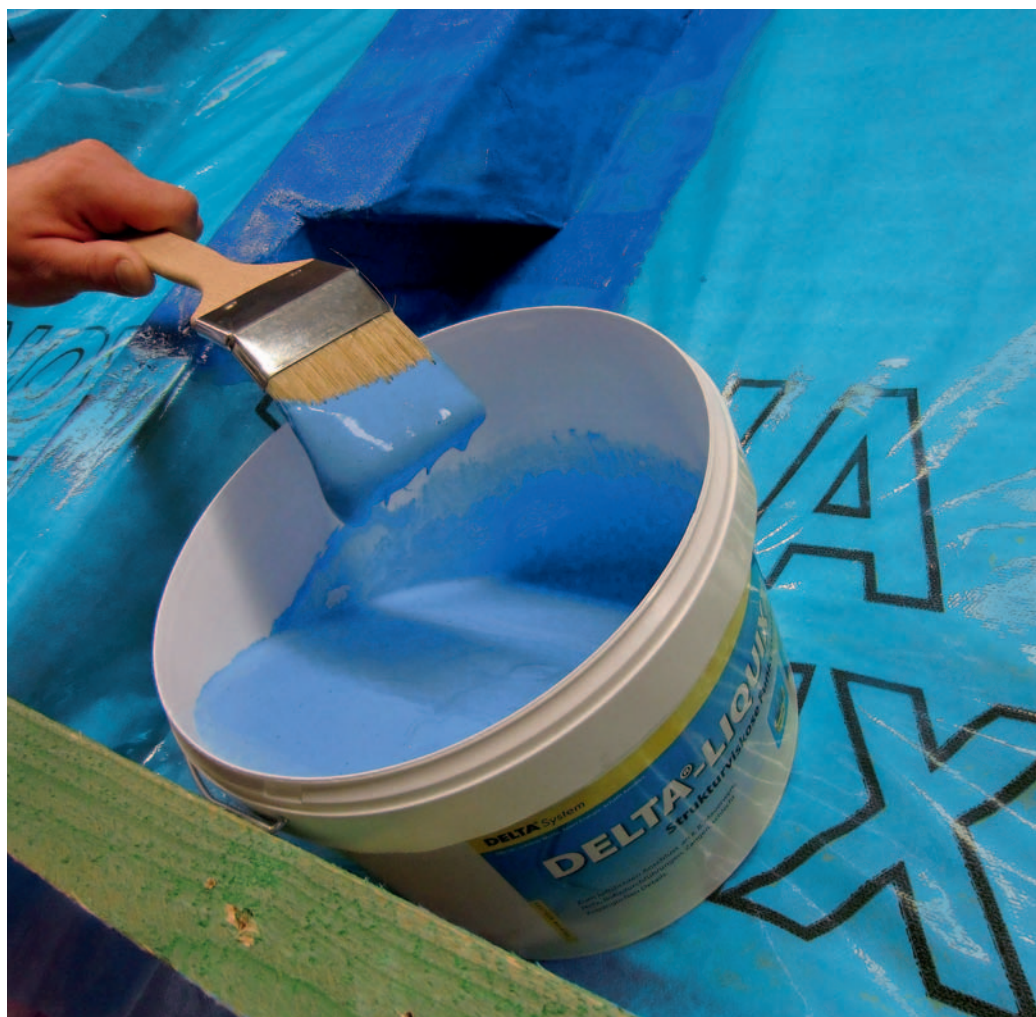
DELTA®-LIQUIXX lässt sich schnell und einfach mit dem Pinsel auftragen.
