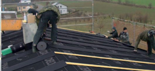
Einfache Montage von DELTA®-ALPINA BAND.
