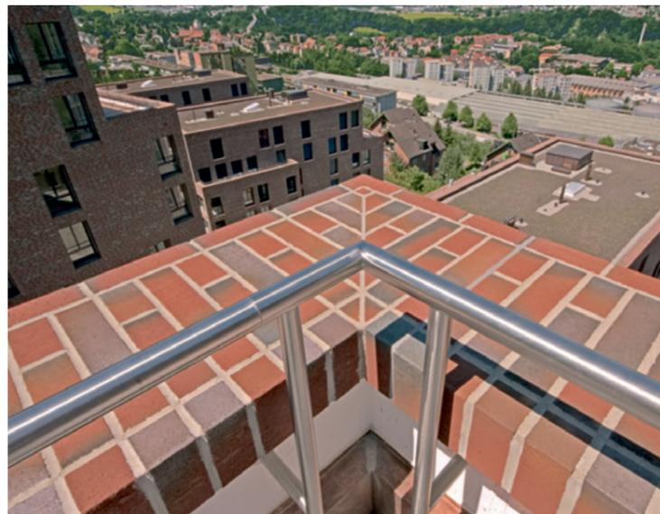
Ein Röben Fertigteil als präzise ausgeführte Mauerwerks-Abdeckung, individuell für das Objekt vom Röben PlanungsService entwickelt und produziert. Hier als Balkon-Brüstung mit drei Sichtseiten.
