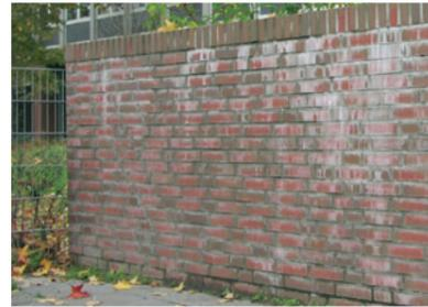
So bitte nicht: Die Oberkante dieser Mauer wurde manuell erstellt. Die Folge: Regenwasser dringt ins Mauerwerk ein und verursacht hässliche Auslaugungen. Mit einer vorgefertigten Mauerwerksabdeckung von Röben wäre das nicht passiert.
