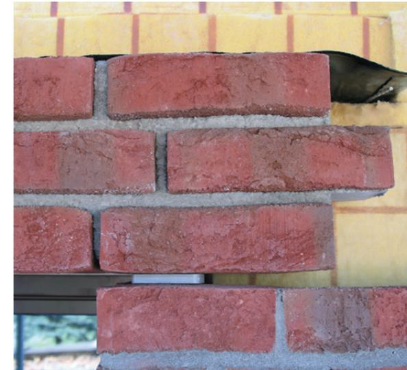
Läufersturz mit Edelstahl-Auflagerplatte in Folie für den Dehnungsfugen-Bereich.
