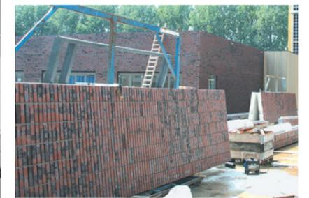
**3** Im Südbereich des Hauptgebäudes wurden alle Brüstungen auch als Fertigteile ausgeführt. Diese Elemente wurden optisch analog denen an der Nordfassade auch im stehenden Verband hergestellt. Diese Balken haben eine Länge von ca. 7 Metern und werden beidseitig mit einer speziellen Stahlkonstruktion auf die dahinter liegenden Stahlbetonstützen der Hauptkonstruktion aufgelegt.
