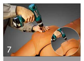
Variante 2: Mit einem Steinbohrer wird ein Loch in die Walmkappe gebohrt. Anschließend wird diese mit einer korrosionsbeständigen Dichtschraube auf der Holzunterkonstruktion fixiert.
