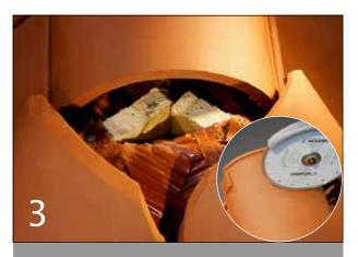
Die First- und Gratziegel werden so angepasst und aufeinander abgestimmt, dass die Walmklappe an allen drei Punkten sauber aufliegt.
