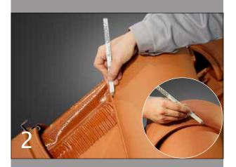
Der letzte Gratziegel wird auf dem Grat aufgelegt und angezeichnet. Danach wird der Gratziegel mit der Trennscheibe passend zugeschnitten.
