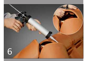
Variante 1: Durch eine Markierung wird die Überdeckung der Walmkappe auf den Gratziegel übertragen. Mit hochwertigem Kleber (frostbeständig und für Keramik geeignet) werden die Walmkappe und die drei Firstziegel miteinander verklebt.
