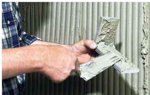
Kleberauftrag im kombinierten Verfahren („Floating-Buttering“)
