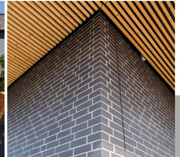
Hier nimmt die Dehnungsfuge die Bewegungsspannungen der Riemchenbekleidung im Eckbereich auf, FARO schwarz-nuanciert
