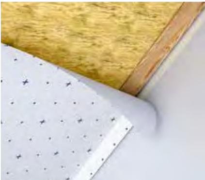
Verklebung und Abdichtung von Dampfsperren im Wandanschlussbereich
